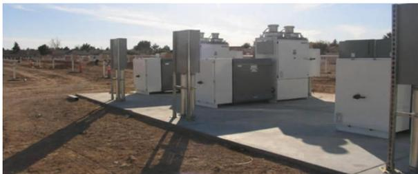
Figure 12 : Exemple de plateforme onduleurs et transformateurs (Source : Sunpower, 2011)
