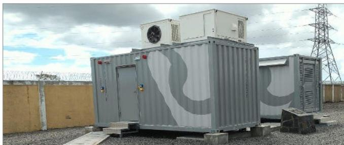
Figure 15: Installation de stockage dans un conteneur 20'
